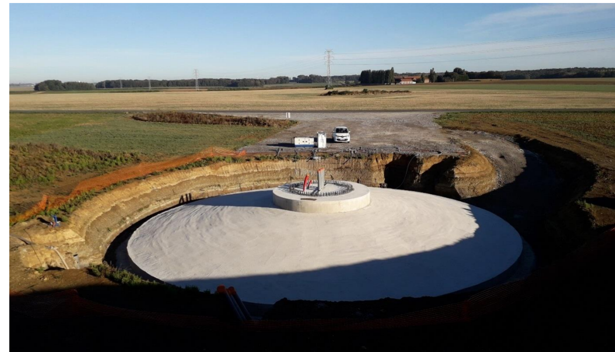
Figure 74 : Fondation après coulage béton (Source : VOLKSWIND)
