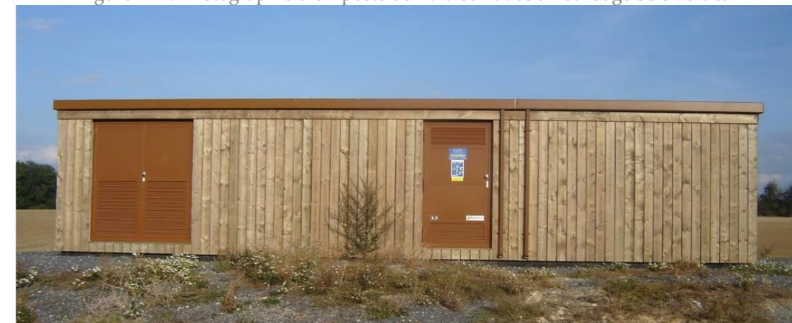
Figure 124 : Photographie d'un poste de livraison avec un bardage bois vertical
