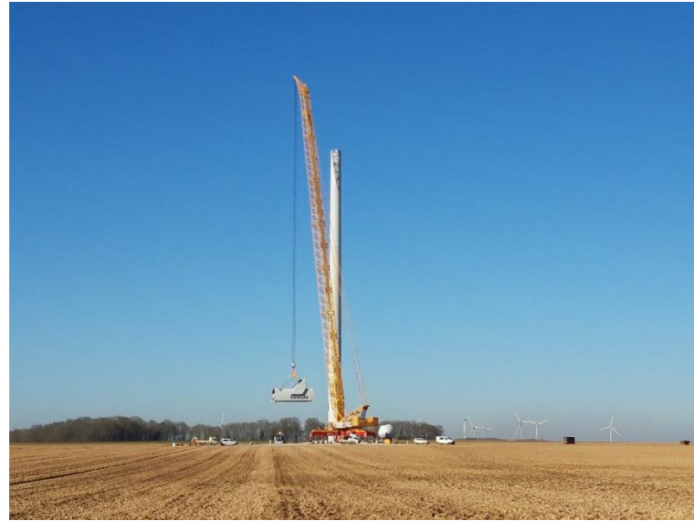
Figure 81 : Montage de la nacelle (Source : VOLKSWIND)
