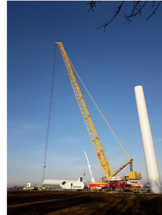
Figure 75 : Grue permettant l'assemblage des différents éléments d'une éolienne (Source : VOLKSWIND)
