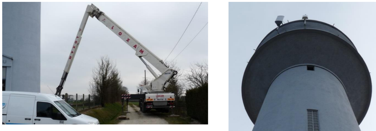
Figure 116 : Installation d'un réémetteur sur un château d'eau
